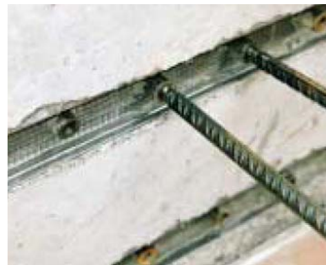
Elementi per le riprese di getto avvitabili
