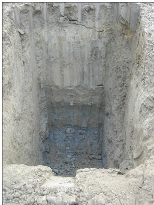
Pozzetto esplorativo eseguito da escavatore
